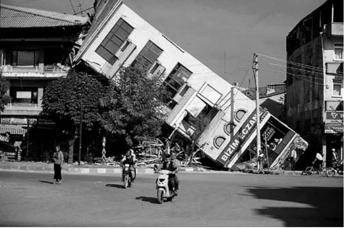
Resim.1: 17 Ağustos 1999 depreminde Sakarya da zemin sıvılaşması nedeniyle yan yatmış bir bina.
