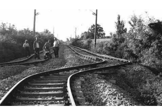
Resim 2: Depremde zarar görmüş demiryolu
