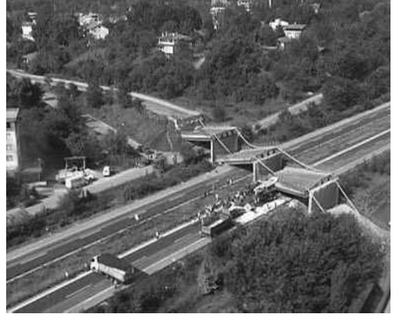
Resim 3: Depremde zarar görmüş bir köprü
